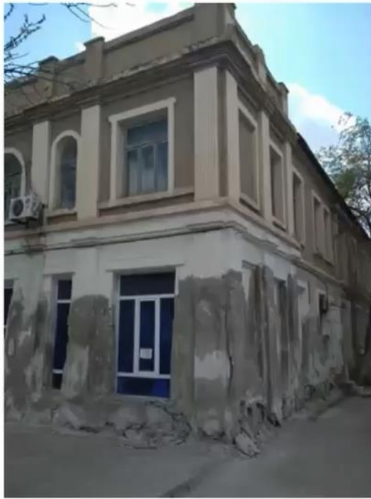
Характер разрушения здания по ул. А.Шамуратовой г. Нукуса (2018 г)
