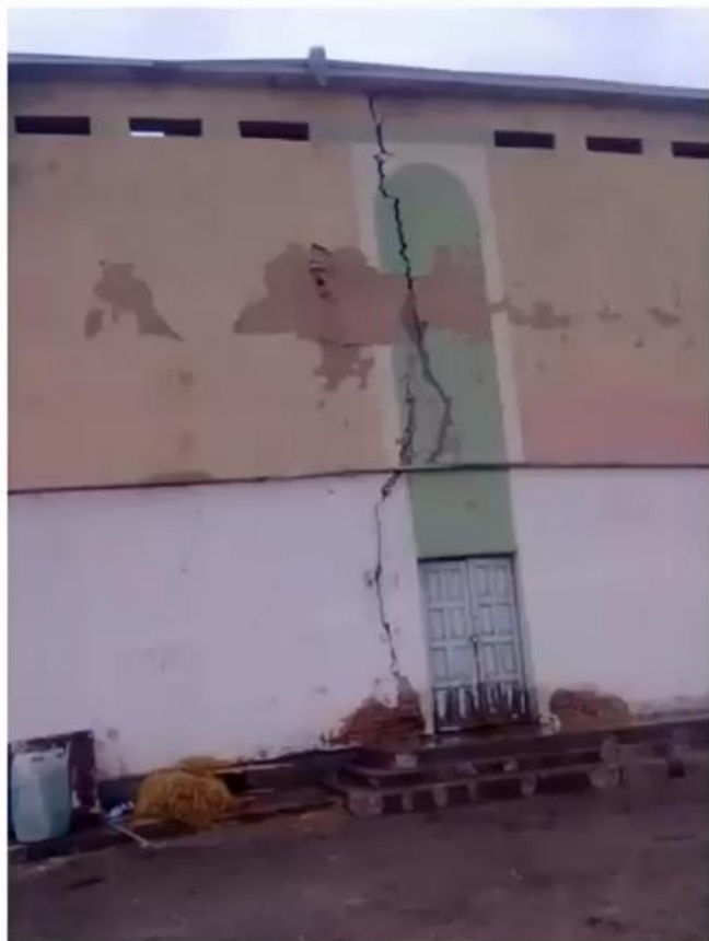
Характер образования трещины в стене кинотеатра (2014 г.)
